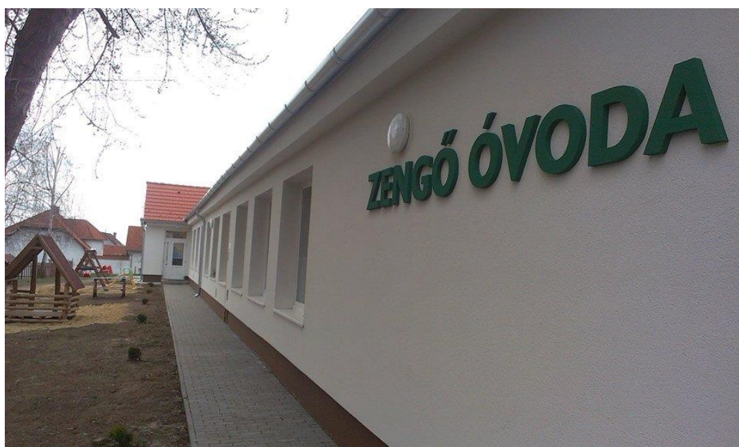
7. kép: Zengő Óvoda- Kindergarten Zengő 30
